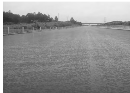
图3 单机全幅摊铺雨后效果
